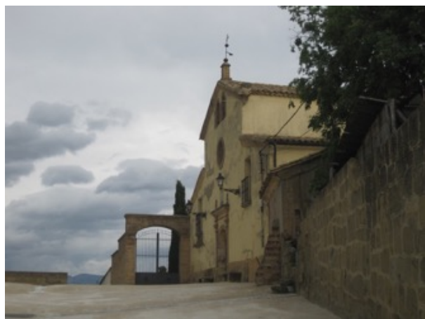
Cima del cerro: ermita y acceso al recinto del cementerio.
