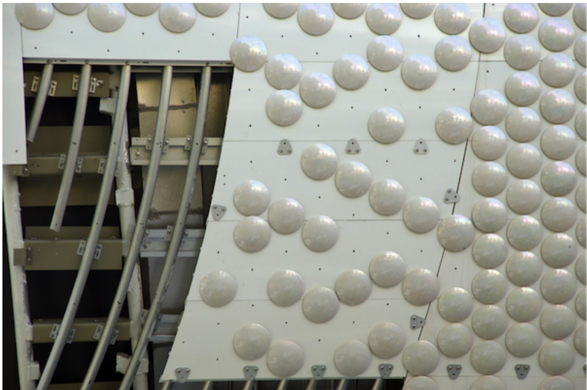
Fig. 6. Santander. Centro Botín. Capas de recubrimiento exterior en proceso de colocación (septiembre, 2016).
