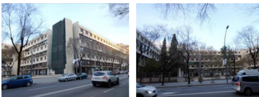
Fig. 1. Dos vistas actuales de la Casa Bloc en proceso de restauración (Para más información sobre esta operación consultar Badillo, 2012) . Imagen CR POLIS. Universitat de Barcelona
